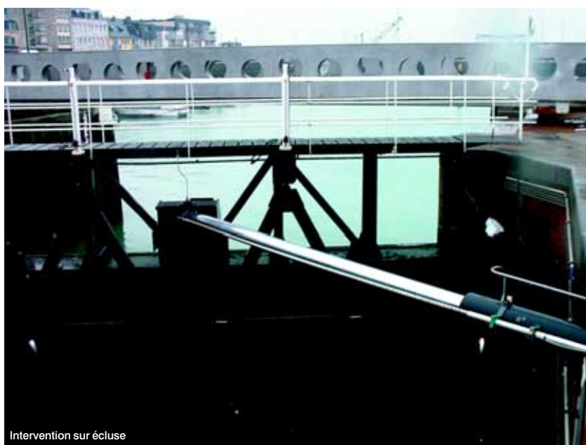
Intervention sur écluse
